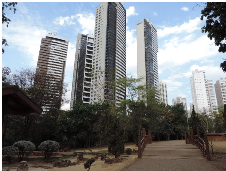
Figura 5.25: Mata de Galeria remanescente e a proximidade dos prédios. Fonte: Acervo da autora (15/09/2014)
