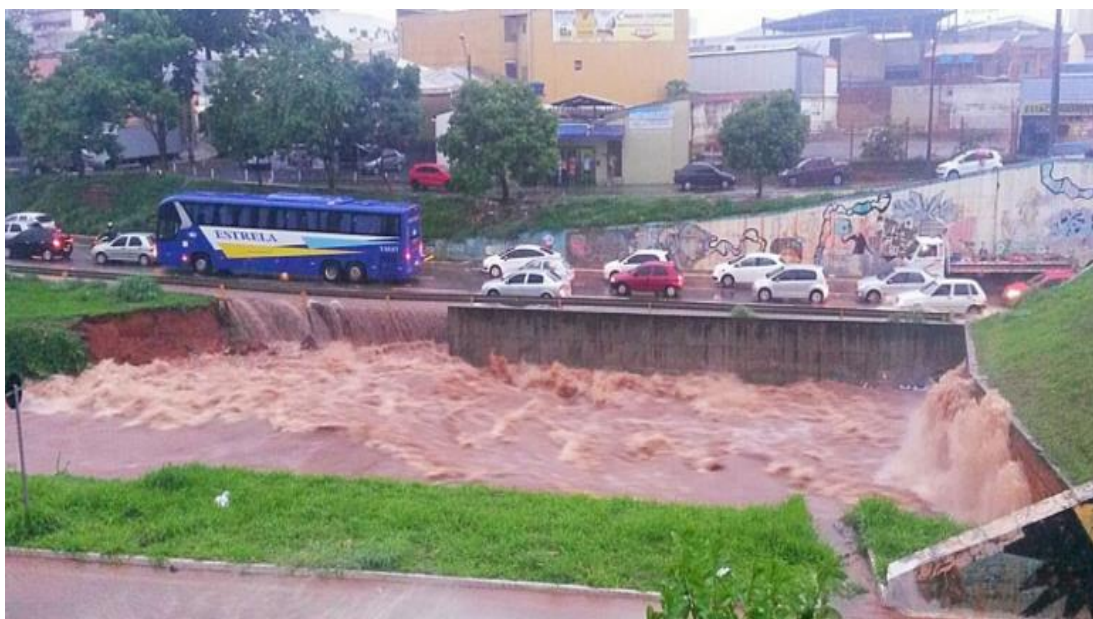
Figura 5.19: Estragos na Marginal Botafogo em função das chuvas – Setor Central.
