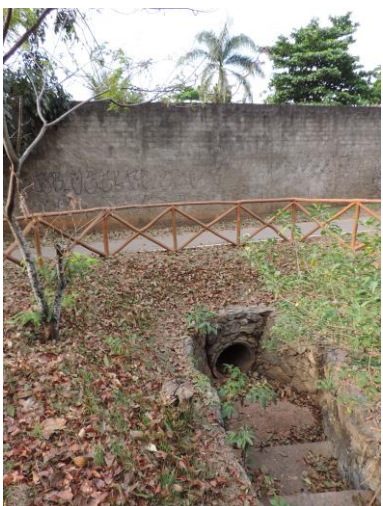
Figura 4.19: Córrego Sumidouro (percurso canalizado subterrâneo). Fonte: Acervo da autora.
