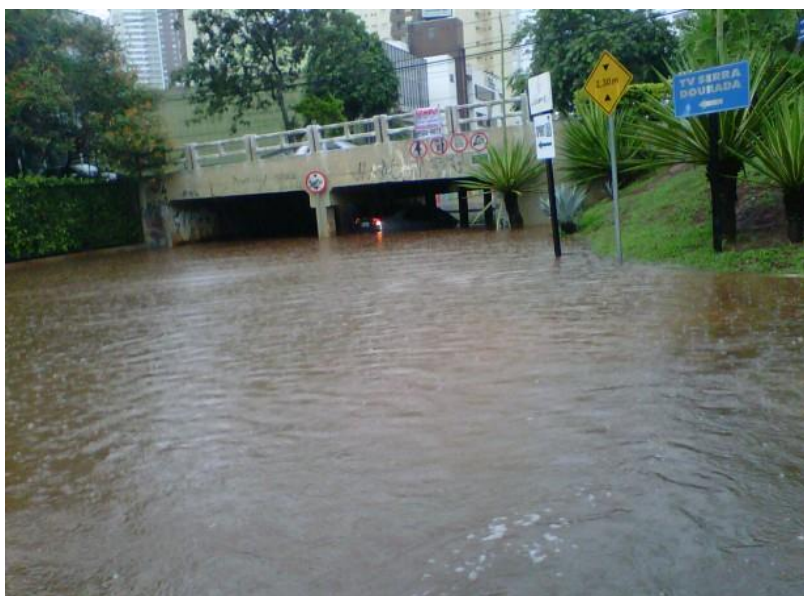
Figura 5.21: Alagamento sob viaduto próximo ao Shopping Flamboyant . Fonte: Goias24horas (06/12/14)
